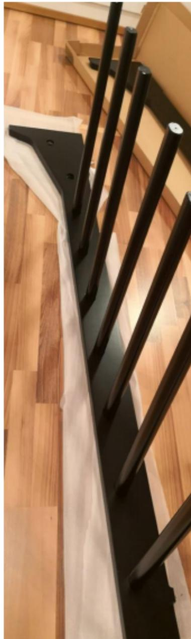
Decken Sie den Boden ab, um Kratzer zu vermeiden. Legen Sie das erste Rahmenteil auf den Boden.
