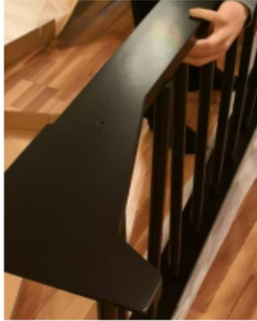
Befestigen Sie das zweite Rahmenteil auf den Sprossen. Fangen Sie an einem Ende an und legen Sie nach und nach die Sprossen ein, bis sie alle fest sitzen. Wenn nötig, nutzen Sie einen Holzblock und einen Gummihammer, um die Sprossen richtig einrasten zu lassen. Achten Sie darauf, dass Sie keine Kratzer auf der Oberfläche hinterlassen. Befestigen Sie drei Sprossen mit Hilfe von drei 6x60 TX 30 Schrauben an einer Seite.
